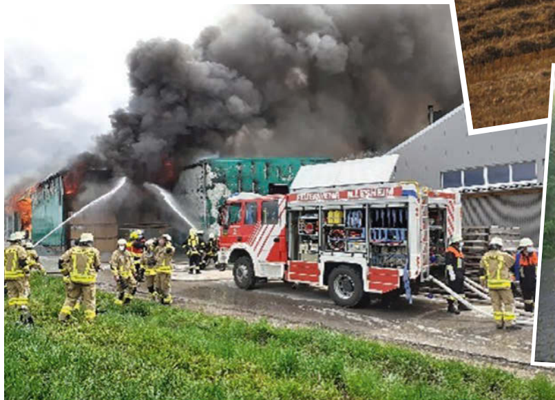
Großbrand bei Fa. E+G in Schwebheim am 13.05.2021
