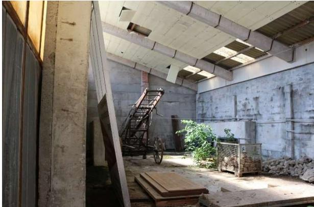
Abb. 4: Lagerhalle mit marodem Dachstuhl, die derzeit als Lagerstätte für Steine dient © Klärle GmbH, 11.06.2021
