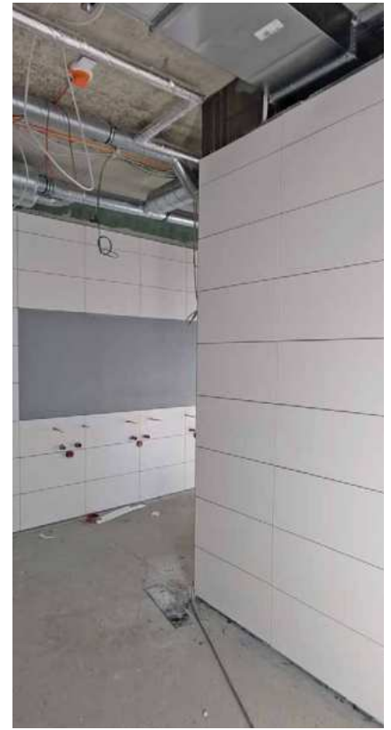
Fliesenarbeiten im WC-Bereich.
