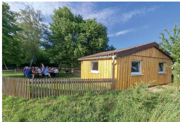
Das Dorfhaus nach Abschluss der Sanierungsarbeiten mit erneuerter Holzfassade, neuer Dämmung und modernen energieeffizienten Fenstern.
