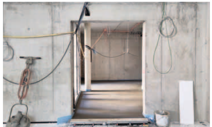
Blick von der Mosterei ins Foyer: Der Estrich wurde gelegt. (Foto: Nadine Höhne)
