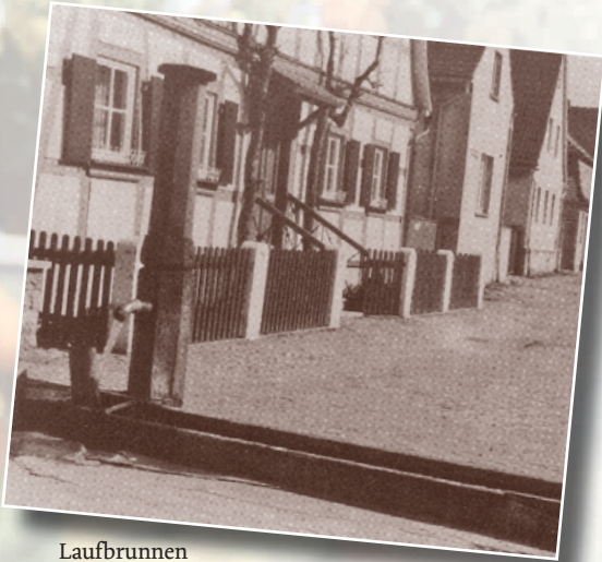
Laufbrunnen Ansbacher Straße
